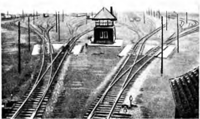
Рис. 20. Механизованная товарная станция: налево и направо от башни управления видны механические стрелочные аппараты для сортировки товарных вагонов.
